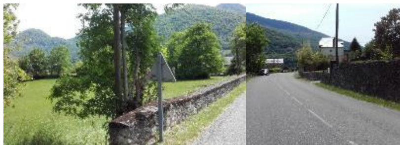
Muret en pierre à conserver le long de la rue du Dr Huguet
