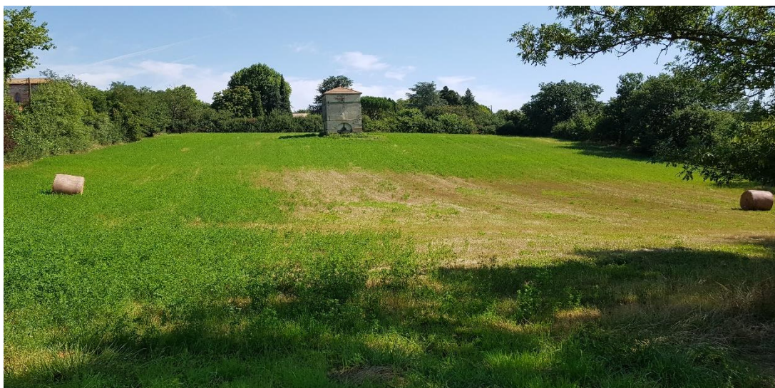
P2 - Vue sur le pigeonnier et ses abords, situés à proximité immédiate de l'OAP
