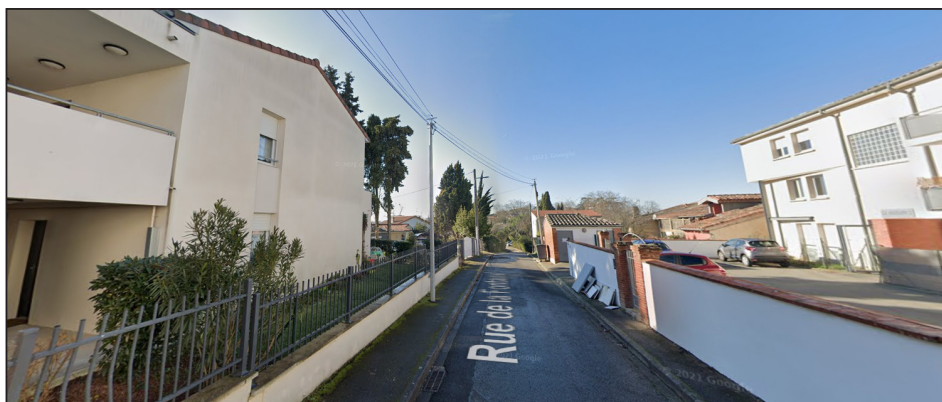
Vue 2 sur la rue de la Fontaine, bordée par des immeubles d'habitats collectifs en R+1 et R+2.
