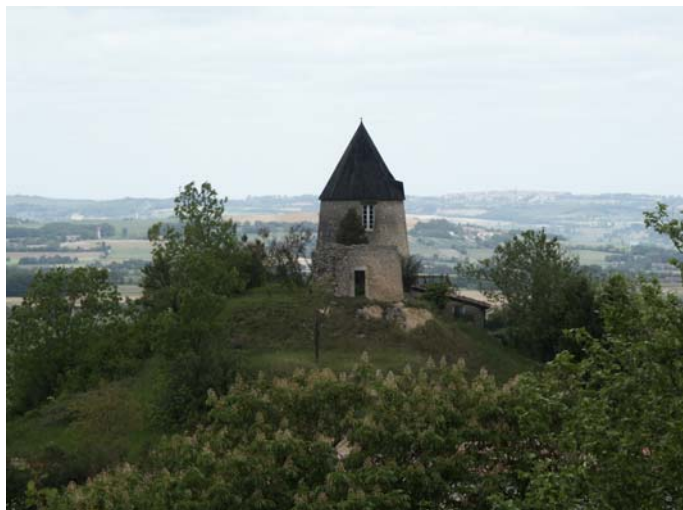
Moulin réhabilité à St Félix
