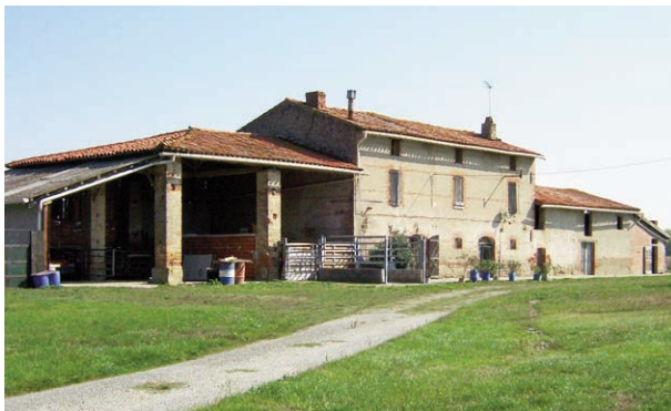
"Rajol"- bâti modeste, anciennement agricole: long bâtiment avec hauteurs multiples; hangar avec poteaux de terre cuite en prolongement du corps principal (ouvert vers le sud)
