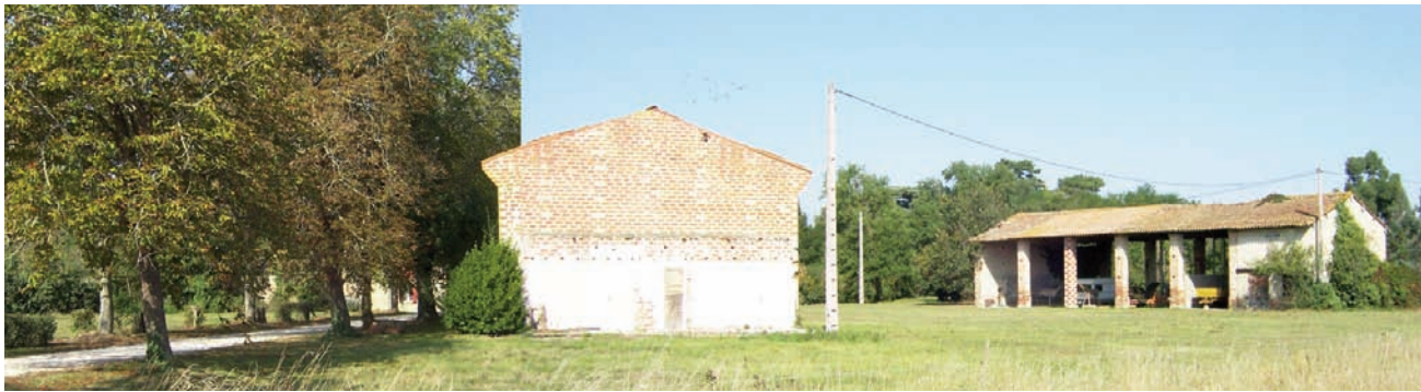
"le Tor d'en haut" - bâti assez soigné, anciennement agricole: plusieurs corps de bâtiments avec hangar avec poteaux de terre cuite et toiture fibrociment
