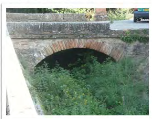
Photos n°2 : Pont amont du bourg.
