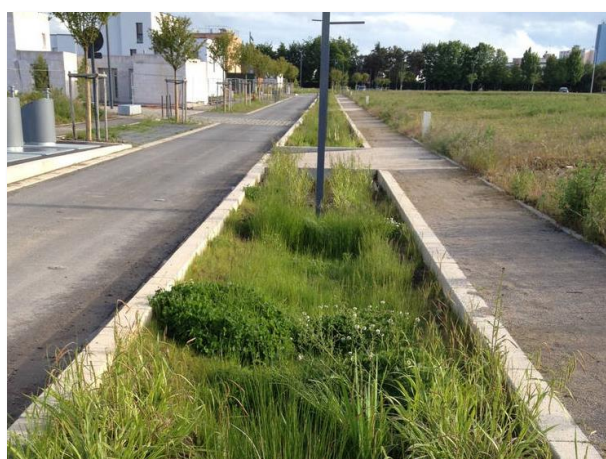
Noue urbaine à plantes semi-aquatiques
