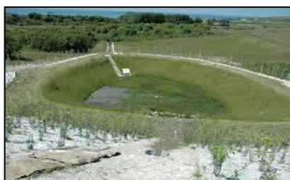
Bassin de rétention
