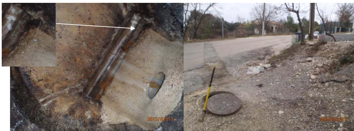
Illustration n°5 : Infiltrations d'ECP par virole dans RV n°112, Grand'Rue à Vic-le-Fesq
