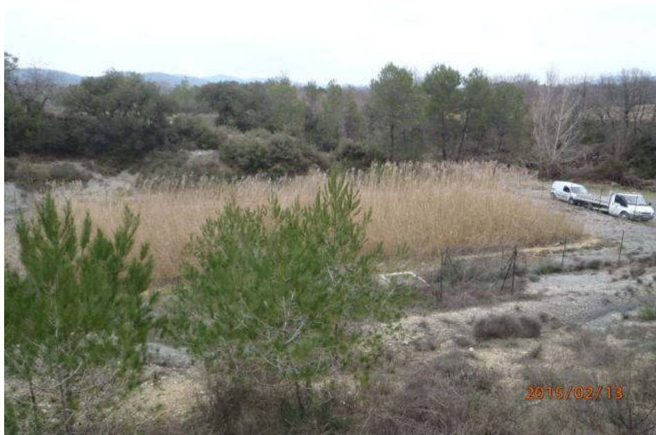
Illustration n°6 : Vue sur le deuxième étage de la station à filtres plantés de roseaux à Vic-le-Fesq
