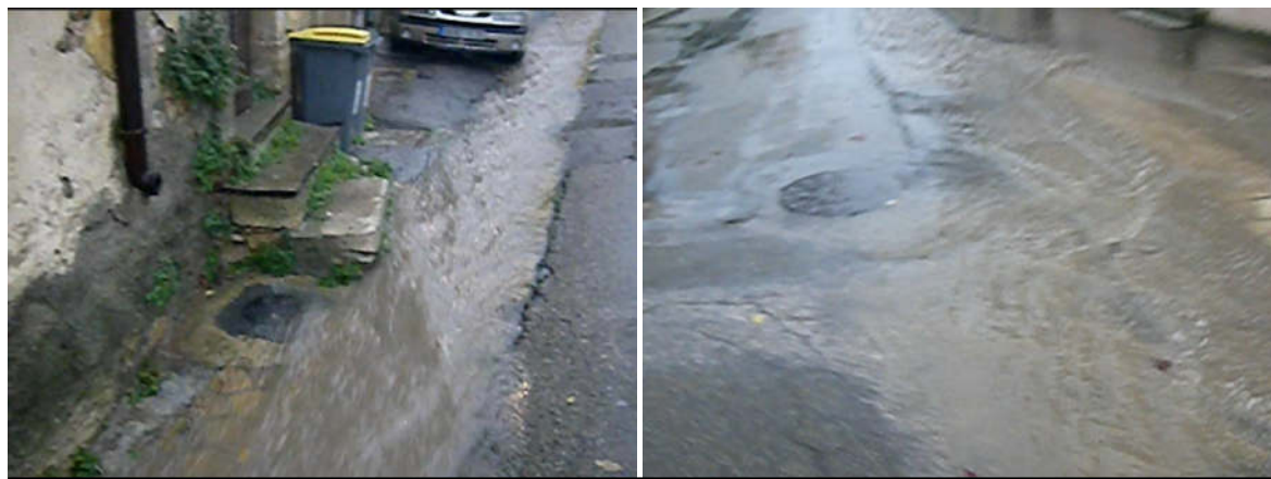
Exemples de ruissellement sur voirie et boîtes de branchement
