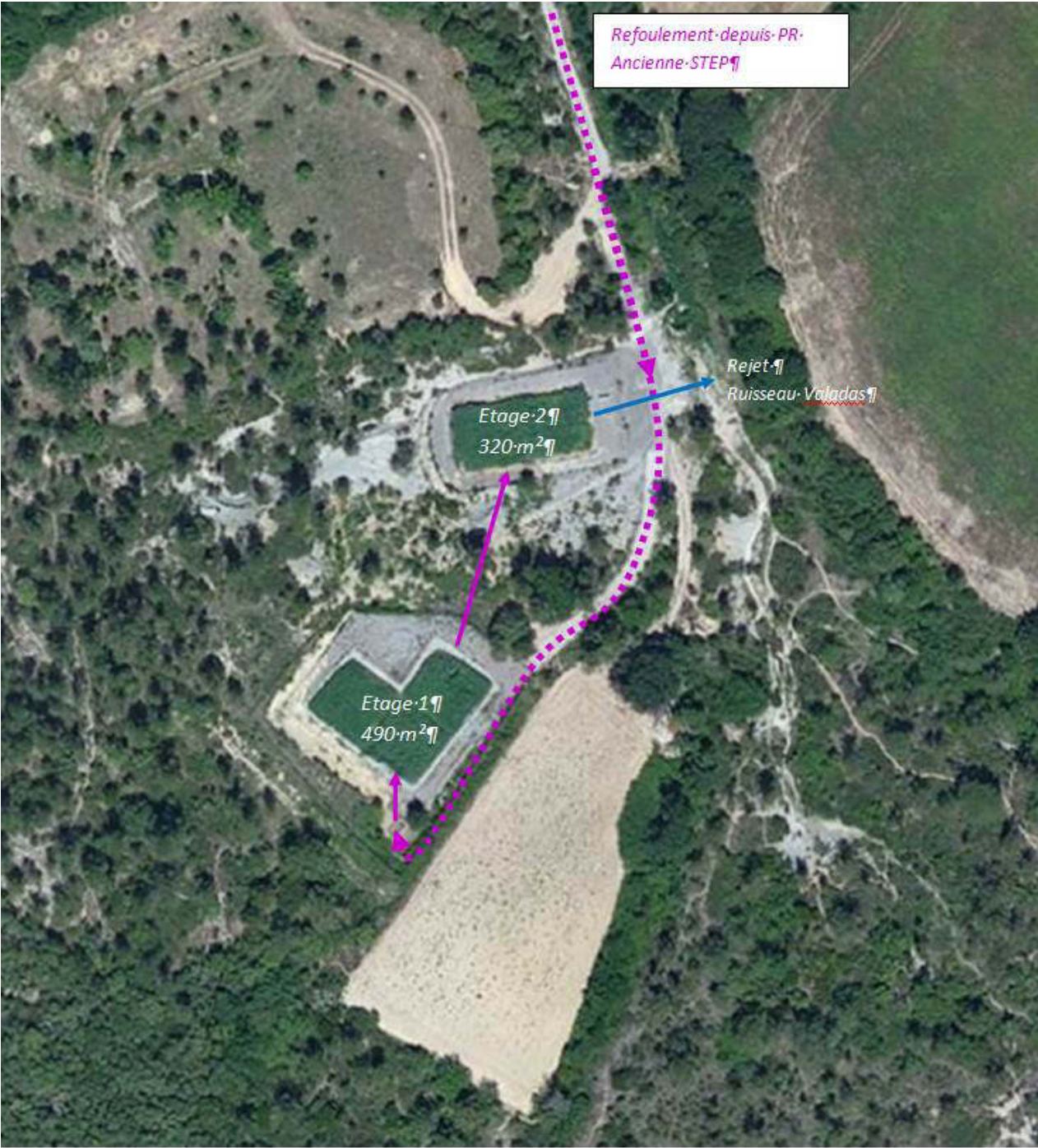
STATION D'EPURATION DE VIC-LE-FESQ EN CONFIGURATION ACTUELLE
