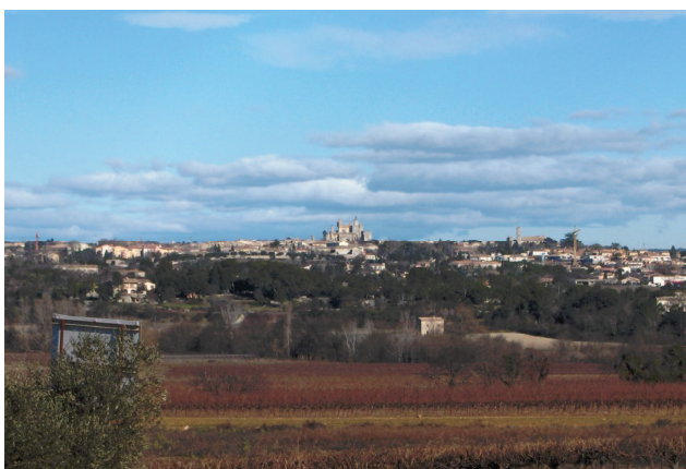
La Cité d'Uzès émergeant sur une plate-forme au sein de la plaine agricole
