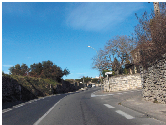
Muret de pierre bordant la future ZAC du Chemin de Nîmes le long de la RD 979
