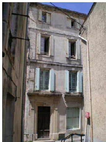
Façade XIXe post-classique à deux travées, deux étages et attique, 23 Grand Rue (secteur centre)
