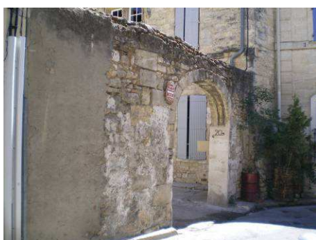
Mur de clôture en moellons enduits et portail en anse de panier de la cour de l'hôtel particulier 20 rue de la Jasse (secteur centre)
