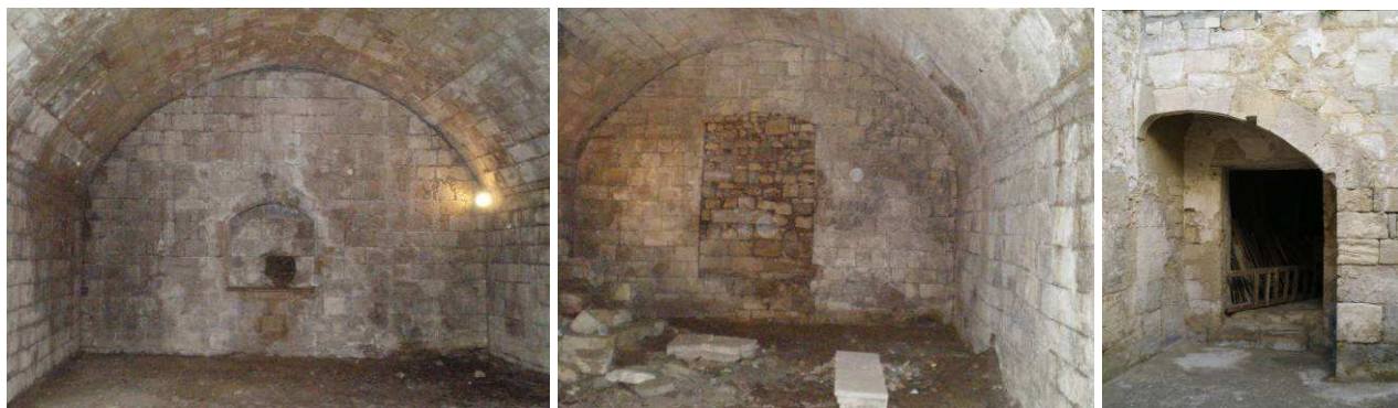
Cave rue Maison romane, (parcelles 81 & 73) et porte d'accès à la cave située sous le rampant d'un ancien escalier.
