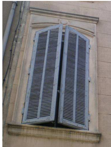
Volets battants persiennés (cas très rares), feuillures pour volets. A gauche, linteau centré, encadrement mouluré sur appui mouluré, à droite, encadrement plat simple.
