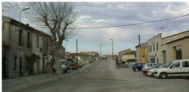
A partir de la route d'Arles : le faubourg à l'entrée sud, constituant de ux fronts bâtis cohérents, surtout à gauche, annonçant l'entrée dans le centre historique (hors secteur sauvegardé)
