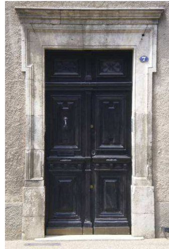
Portes néo-classiques à encadrement simple, à cadre et panneaux, impostes pour les 2 de droite
