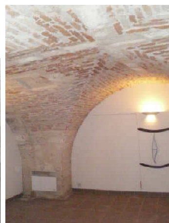
Cave voûtée d'arête, en brique et pierre, 18 place de la République (secteur centre)
