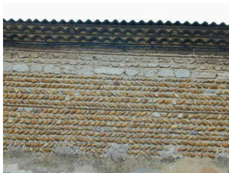
Mur de galets et moellons de calcaire soigneusement appareillé (sans doute destiné à rester apparent)
