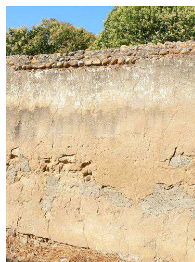
Mur de clôture en galets enduits au mortier de chaux, sable impur donne la teinte ocre. La dégradation de l'enduit permet de lire l'appareillage des galets, noyés dans le mortier afin d'éviter qu'ils ne moulent
