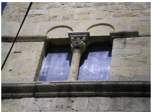
Baie rue Ernest Blanc (parcelle 1109)
