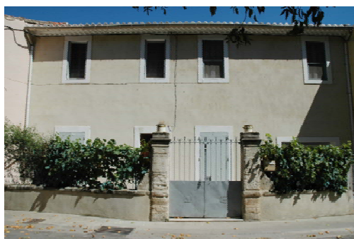
Mur bahut de moellons enduits, piles de pierre de taille, portail et grille fer de la cour du 27 avenue Griffeuille (secteur canal)
