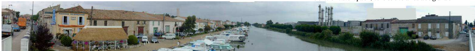
A partir du pont de la route d'Arles : vue vers l'est et le port de plaisance aménagé dans les années 1980
