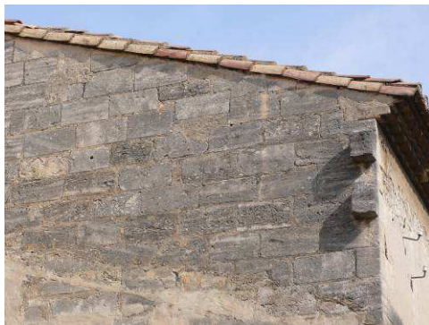
Détail de calcaire d'appareil
