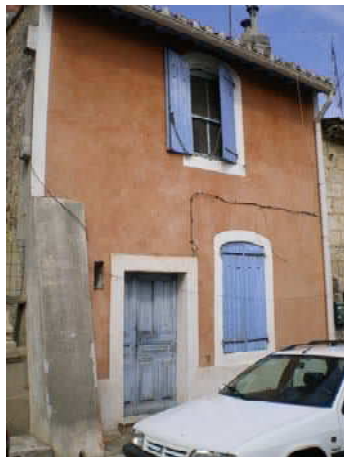
Façade de maison modeste XVIIIe, organisation aléatoire et un étage, rue André Chanson (secteur centre)
