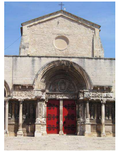
Façade de l'abbatiale
