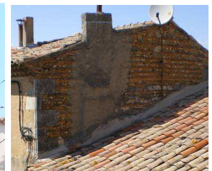
Pignon réalisé en rangs de moellons et de briques alternés, avec chaîne d'angle en pierre d'appareil (sans doute destinés à rester apparents)
