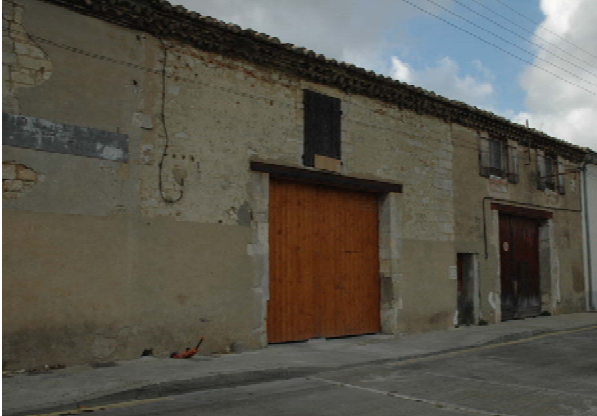
52 Quai du Canal (parcelle 1448)
