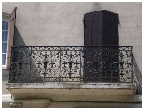
Balcon de récupération posé sur une façade XVIII e , l'allège de la fenêtre a été abaissée, 9 place Frédéric Mistral
