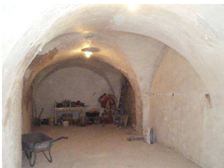
Cave voûtée d'arête, en brique et pierre enduite à la chaux, 32 rue Hoche (secteur centre)
