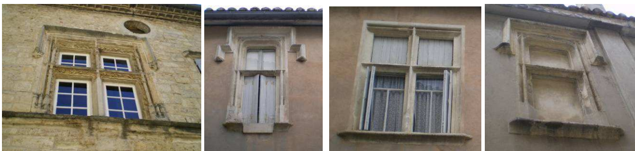
Fenêtre à croisée Rue de la Jasse (parcelle 992) et 4 rue Marcel Pagnol (parcelle 2456)
