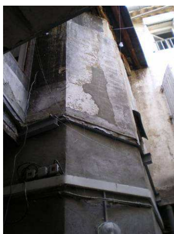
Tour de l'escalier hors œuvre sur plan orthogonal 12 rue Porte des Marchaux (secteur centre)
