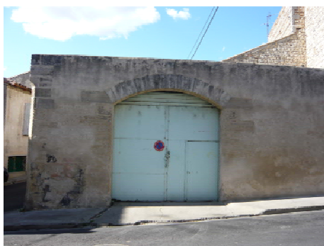
Mur de moellons enduits, à couronnement de mi rond. Encadrement portail de pierre de taille, linteau en arc tendu, porte moderne sans intérêt, rue Emest Renan (secteur faubourg)
