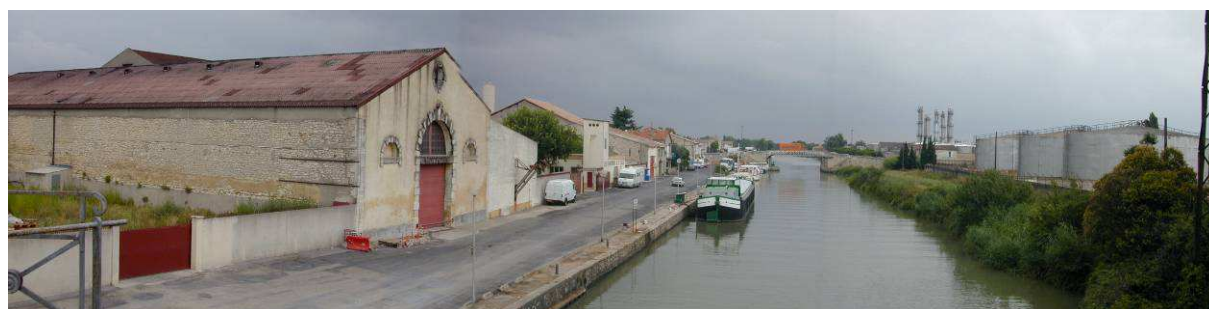
Au niveau de la coopérative : des potentialités d'aménagements
