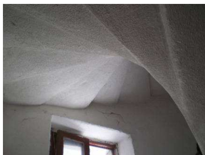
Escalier en vis à noyau plein, 24 rue Porte des Marchaux. Détail de la sous-face des marches
