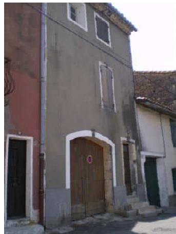
Façade de maison XVIIIe, organisation aléatoire, un étage et attique, 8 place de la Brèche (secteur centre)
