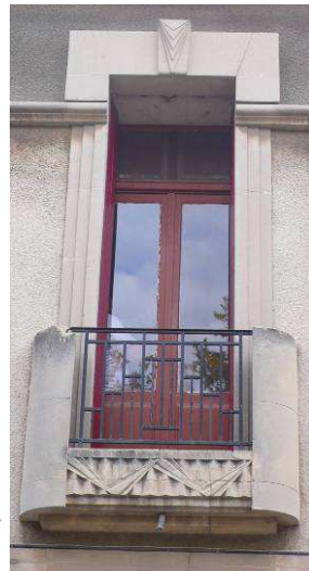
Fenêtres début XXe à grands carreaux et imposte fixe. À gauche, encadrement et balconnet de style Art déco. À droite, encadrement mouluré à crosettes, appuis saillants moulurés et balconnet en fonte néo-classique
