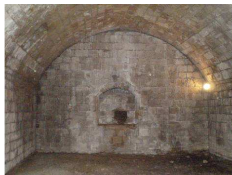
Cave voûtée en berceau, en petits moellons appareillés, rue Joli (Secteur centre)
