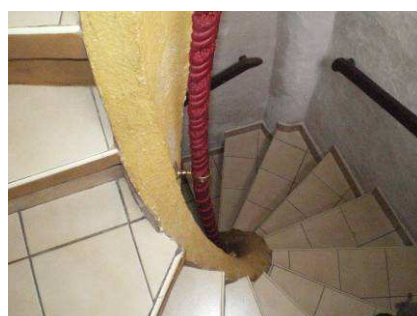
Escalier en vis sur limon, 11 Grande Rue (secteur centre)
