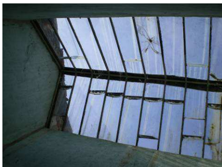
Venière zénithale de l'escalier du 3 rue de l'Hôtel de Ville (secteur centre)
