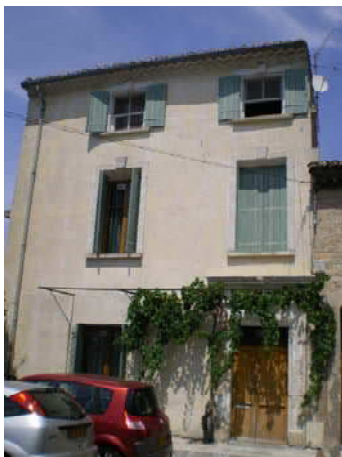
Façade XIXe post-classique à deux travées et un étage, 7 place Ernest Blanc (secteur centre)
