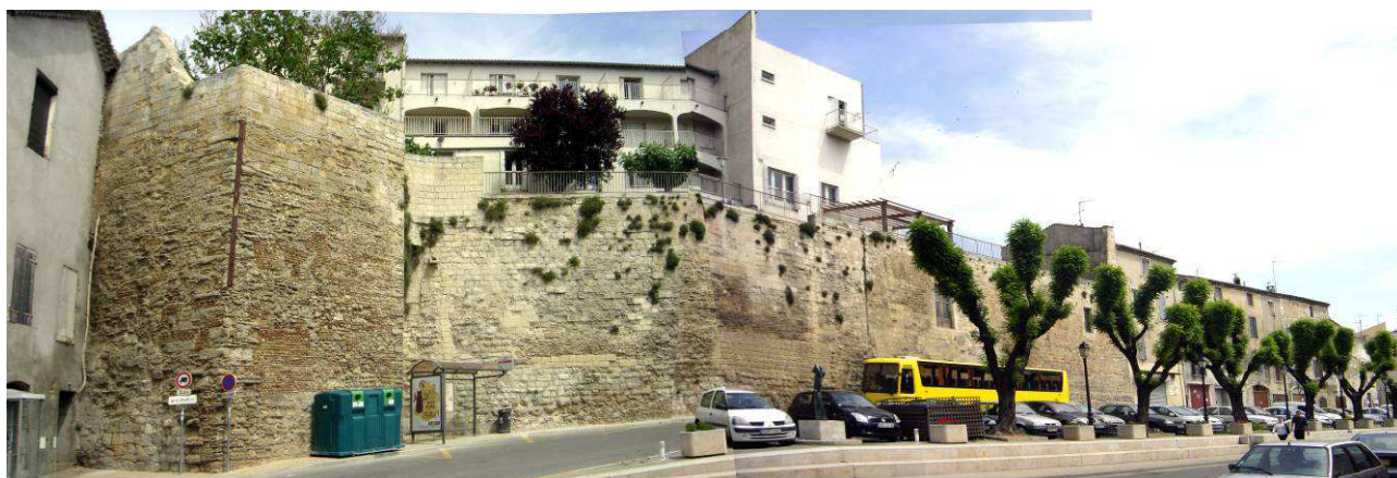
Vue générale du rempart ouest au niveau de la place Frédéric Mistral
