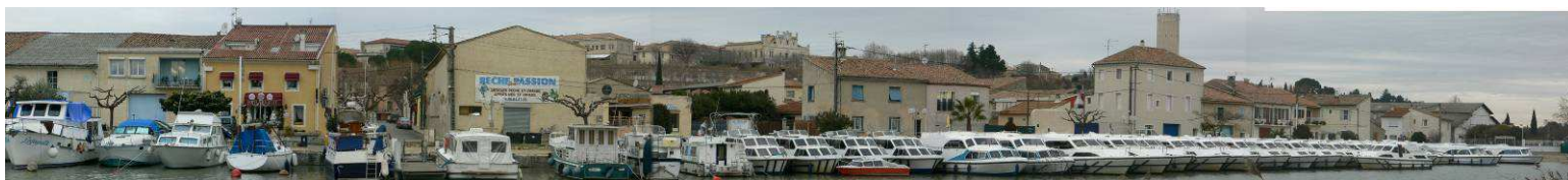
Le quai du Canal nord à partir de la rive opposée, vers le sud (photo du haut), grande homogénéité du front bâti constitué d'anciens entrepôts, vers le nord (photo du bas), le front bâti est moins cohérent, avec des ruptures importantes
