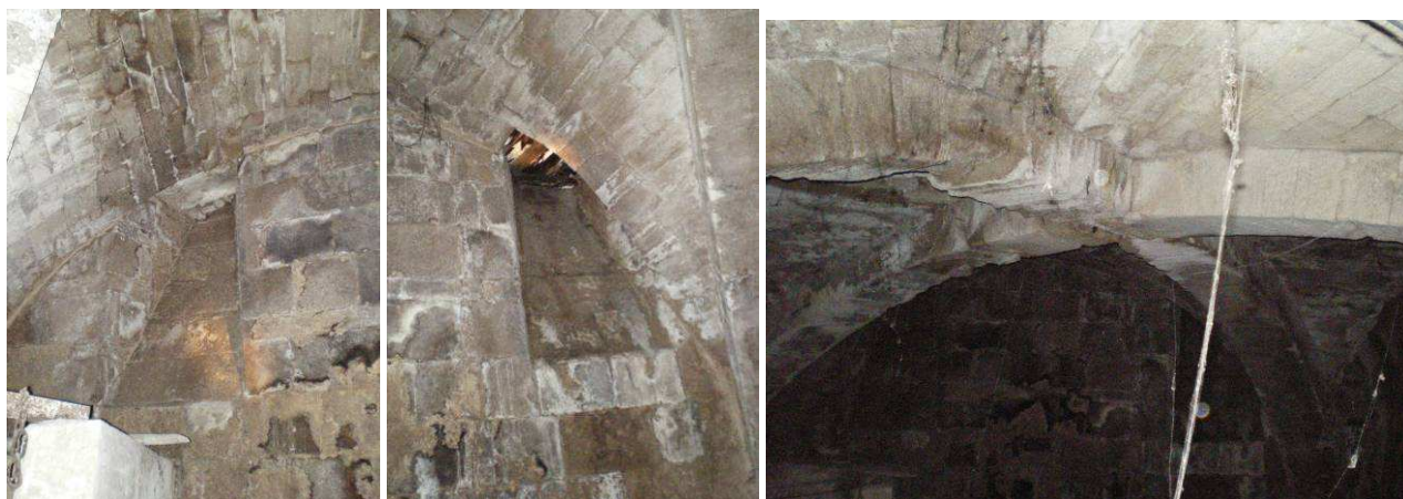
Cave située sous l'immeuble n° 1 rue Saint-Gilles. Soupiraux et voûte d'ogives.
