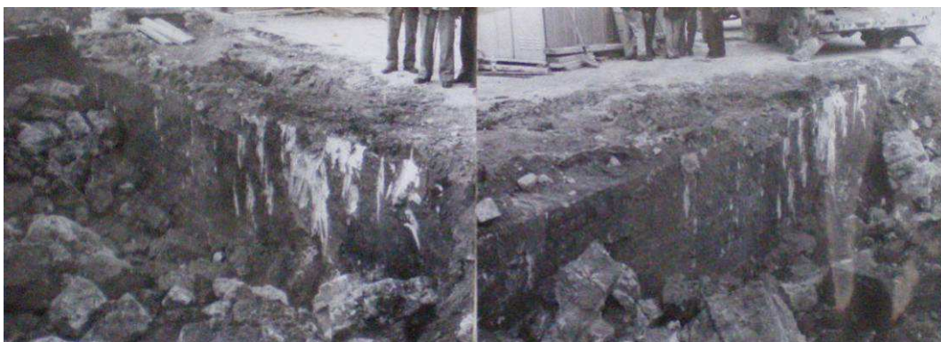
Découverte du tracé du rempart au niveau de l'ancienne porte du Merdançon dans les années 1970. Les maçonneries ont été mises au jour sur une profondeur de plus de 2 m sous le niveau de la chaussée. (Cl: Coll. privée JP Violet)
