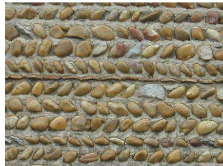
Détail d'appareillage de galets avec un rang de tuiles
