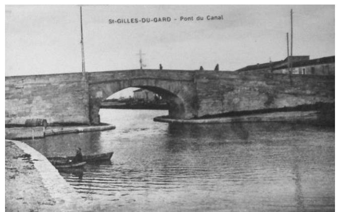
Le pont avec la rampe d'accès reconstruite.
