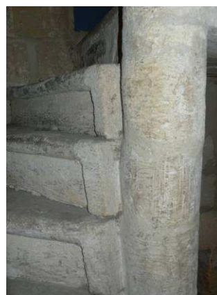
Escalier en vis à noyau plein, détail des marches
