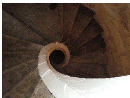
Escalier en vis sur limon, 5 place de la Poissonnerie. Détail du limon évidé
