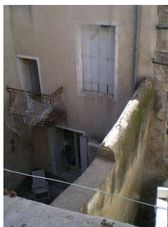
Courte 5 rue de l'hôtel de ville. Le mur avec la courte moyenne pourrait être abaissé afin d'offrir un meilleur rapport de lumière (secteur centre)
