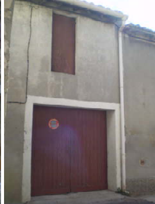
Rue du Puits Salins (parcelle 365)
