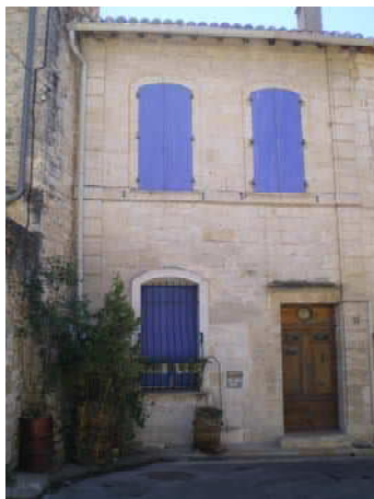
Façade XVIIIe classique simple à deux travées et un étage, 18 rue de la Jasse (secteur centre)
