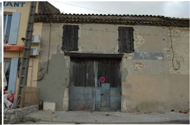
56 Quai du Canal (parcelle 2320)
