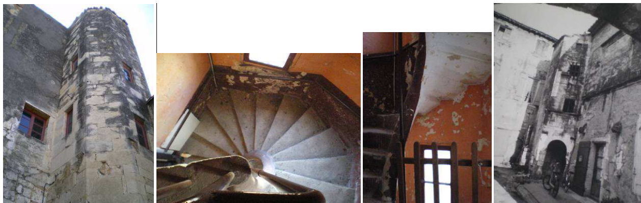
Cage d'escalier à pans coupés et escalier en vis sur limon. Rue Ernest Blanc (Mairie)
