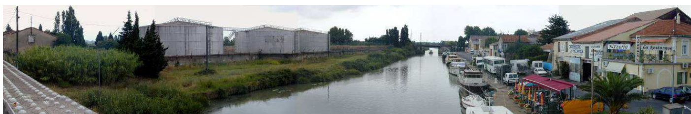
A partir du pont de la route d'Arles : vue vers l'ouest et le quai à requalifier
