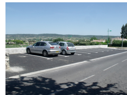
Stationnement Route de Nîmes
