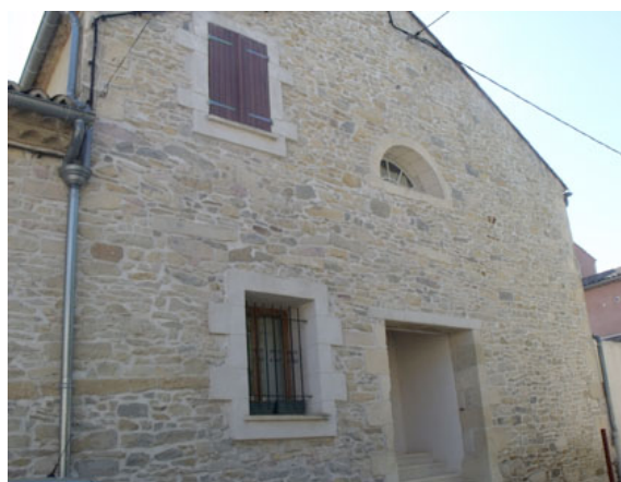
Bâti rénové Rue Bécagrun
