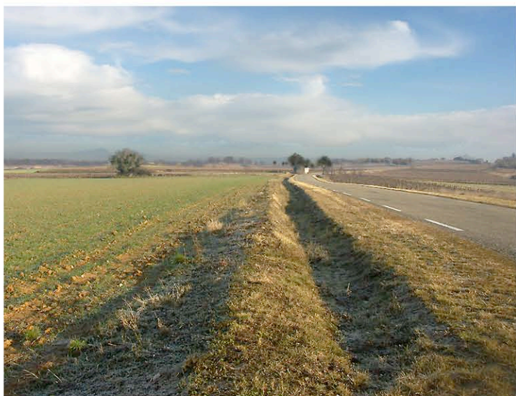
Écoulement pluvial le long de la route départementale n° 210 a en limite communale est.
