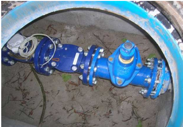
Prise d'eau du Gouffre Noir : Compteur de production sortie
