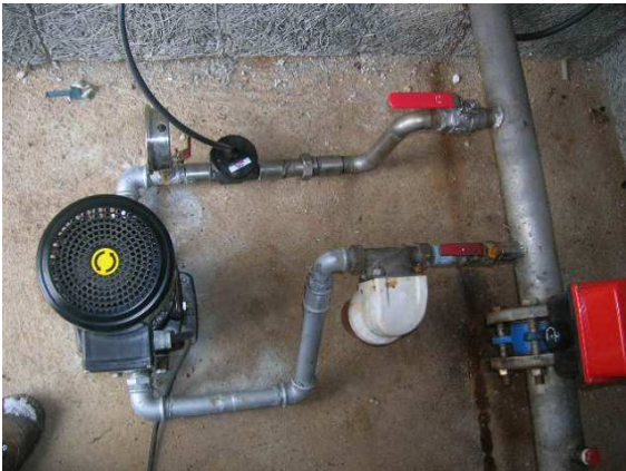
Forage de Chantepedrix: Chloration
