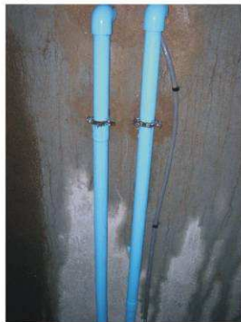
3 Vue des conduites de trop plein et d'arrivée
