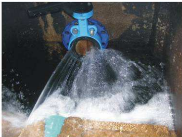
② Arrivée d'eau dans l'ouvrage
