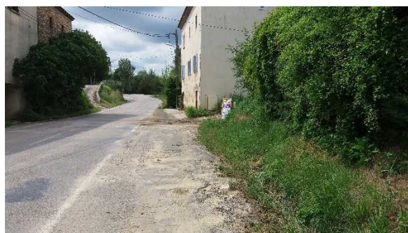
Vue de la D106 vers l'aval
