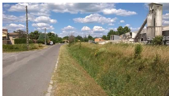
Vue du fossé du chemin de la Cave
