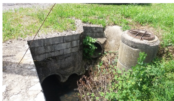
Vue de l'arrivée des réseaux pluviaux avant la traversée sous la D6110
