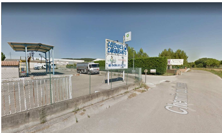
Vue du dépôt de carburant
