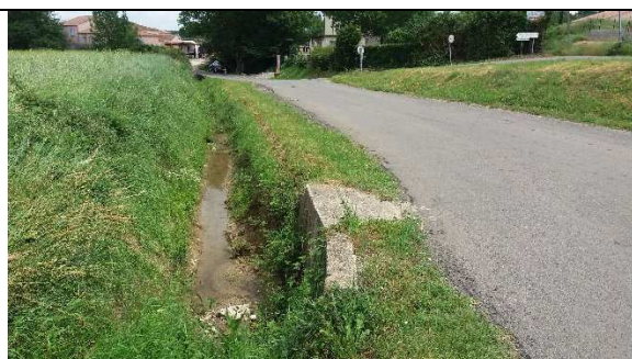
Vue vers l'aval du fossé le long du chemin Cavalier
