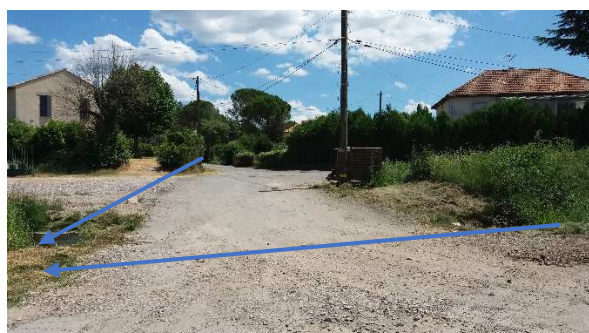
Vue du bas de la rue des Ecoles avec arrivée des fossés
