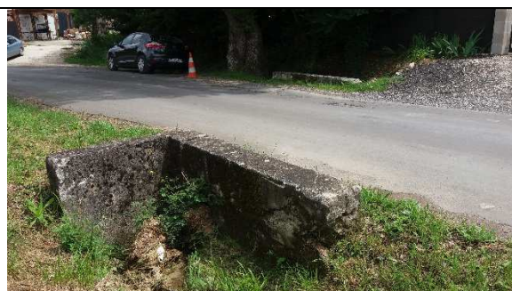
Vue vers l'aval de la traversée du fossé sous le chemin Cavalier
