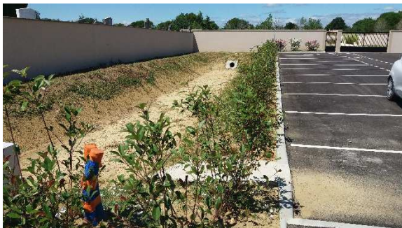
Vue du bassin de rétention près du cimetière de Ribaute
