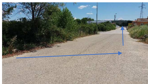
Busage du cours d'eau vers réseau pluvial de l'avenue des Artisans
