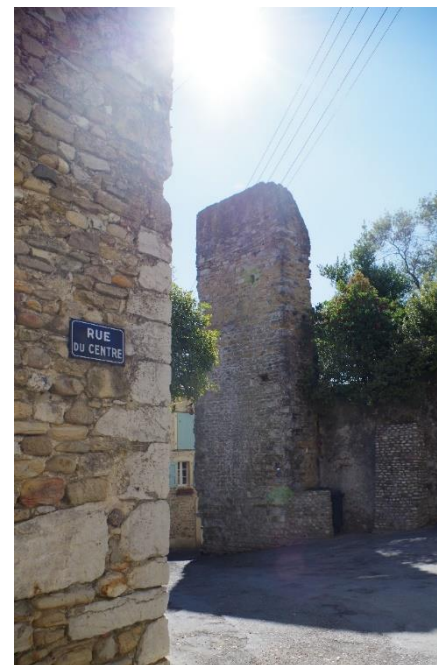
12. La Tour de Ribaute, place de la Tour, parcelle N°AS 356
