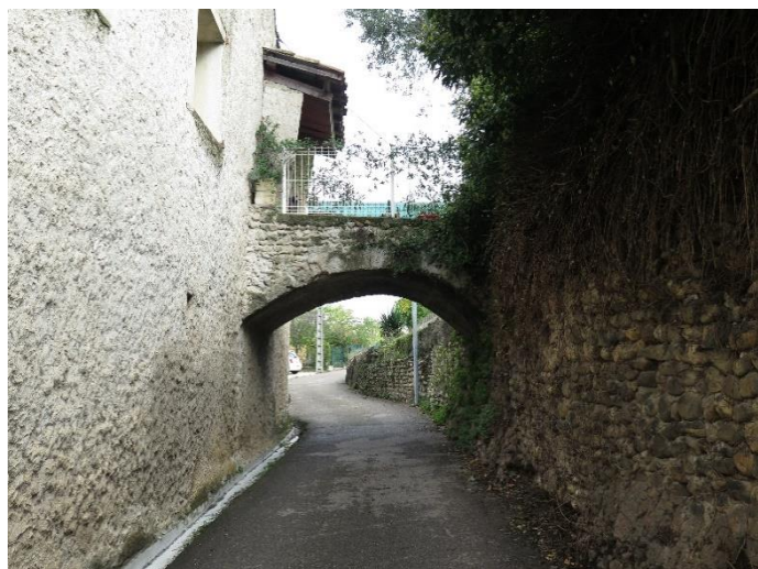
9. Passerelle, rue des Ecoles aux Tavernes,
