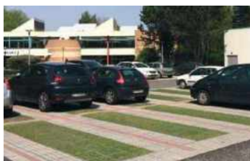
Dalles alvéolées engazonnées ou non
