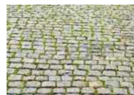
Pavés joints enherbés
