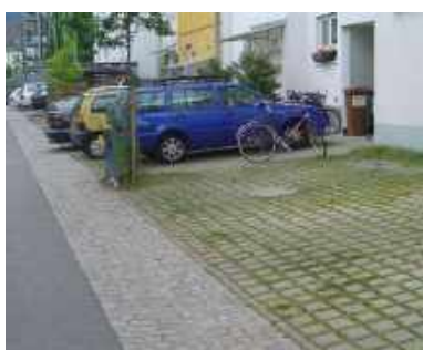
Pavés joints enherbés
