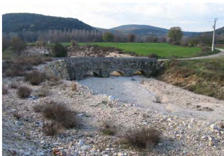
Phénomène de sur-sédimentation au niveau d'un ouvrage hydraulique.
