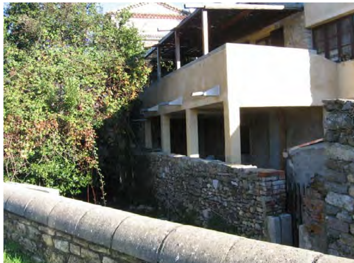
Habitation riveraine faisant office de digue latérale
