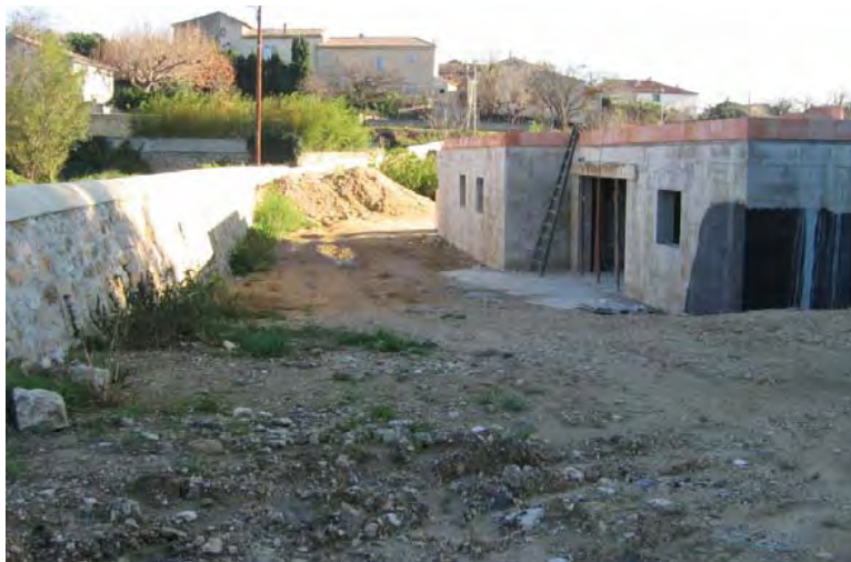
Habitation en construction dans la plaine alluviale du Valbonne
