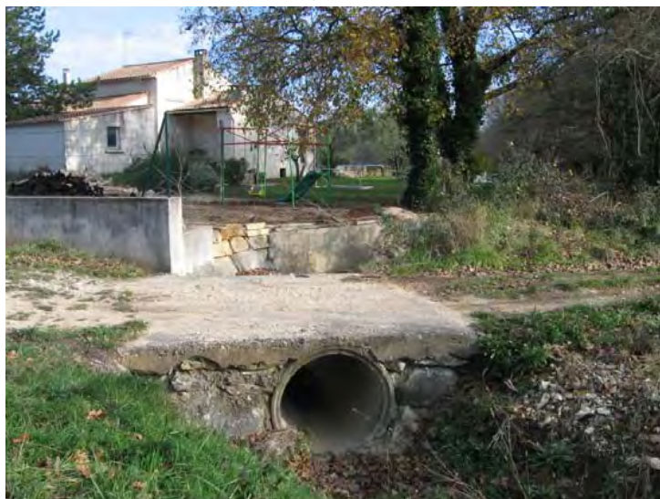
Ruisseau canalisé et enjeux dans sa plaine alluviale
