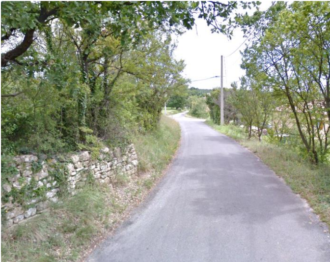
Talus le long du chemin du Rieu
