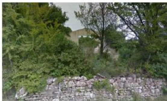
au sud-ouest : un poulailler en ruines, un mur en pierre sèche le long du chemin du Rieu
