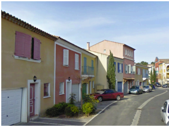
Exemple de maisons accolées et en alignement sur rue. Travail sur les couleurs d'enduit et la différenciation des maisons entre elles.
