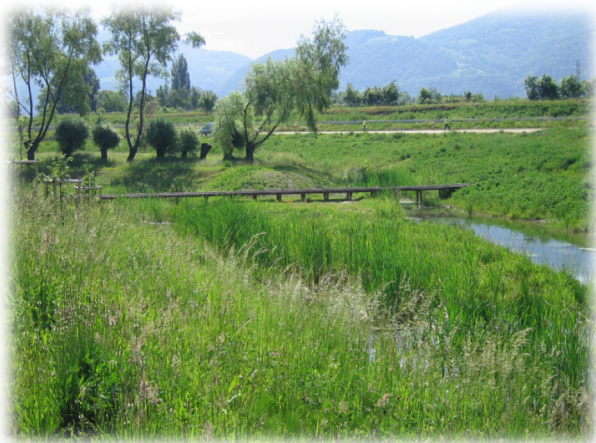
Gestion des eaux pluviales : Bassin de rétention paysager (Ville de Meylan - Isère)
