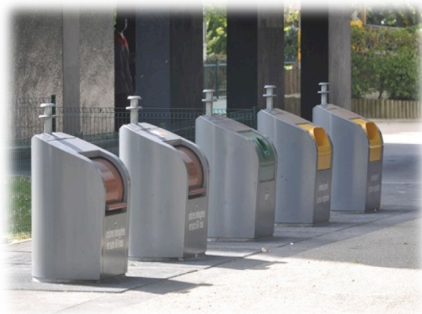
Gestion des déchets : Containers enterrés (Ville de Saint-Gartien – Val d'Oise)
