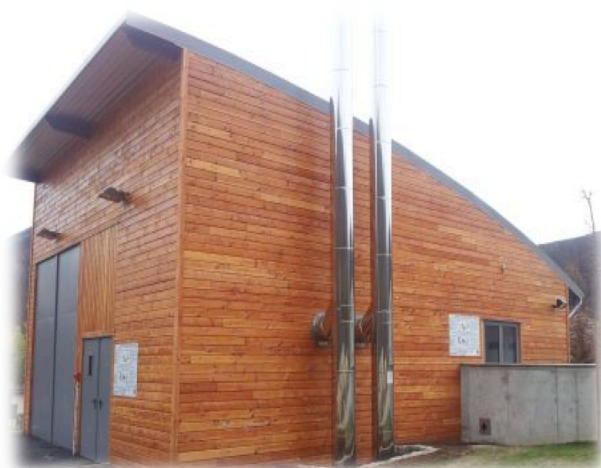
Procédés d'éco-construction : Chaufferie bois collective (Ville de Montpezat sous Bauzon – Ardèche)
