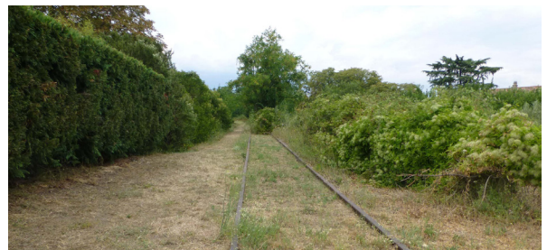
Traces de l'ancienne ligne de chemin de fer : potentiel de mise en valeur d'une circulation douce et d'une délimitation urbaine de qualité
