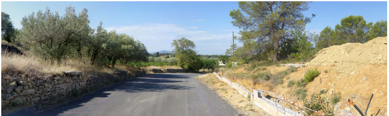
Les aménagements récents ne tiennent pas compte des caractéristiques spécifiques du paysage. Traitement du chemin en creux et des talus (à gauche muret de pierres ancien, à droite muret en agglos en cours de construction).
