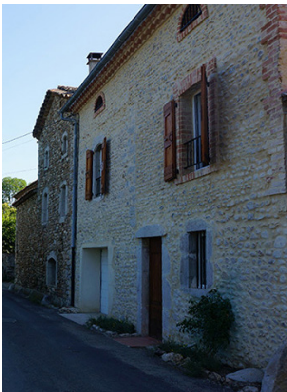
Belle rénovation à Atuech et reprise des encadrements en brique
