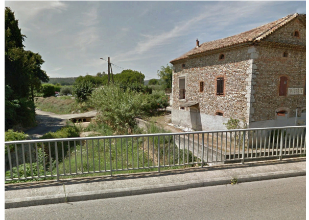
Traversée urbaine du ruisseau de Peironnelle non valorisée
