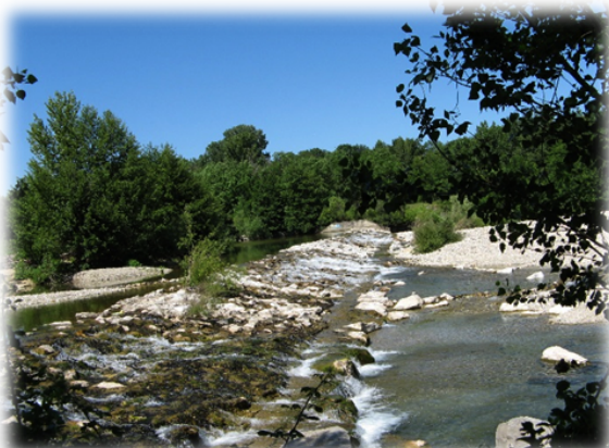
Seuil sur le Gardon d'Anduze au niveau de la commune de Massillargues-Atuech
