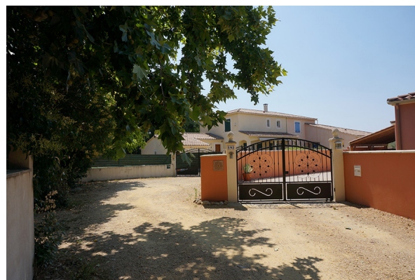
Des accès souvent complexes
