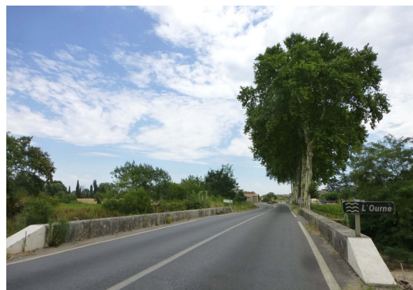
Entrée Ouest sur le territoire de Massillargues-Atuech
