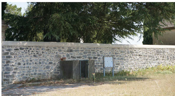
Containers pour déchets verts le long du mur du cimetière
