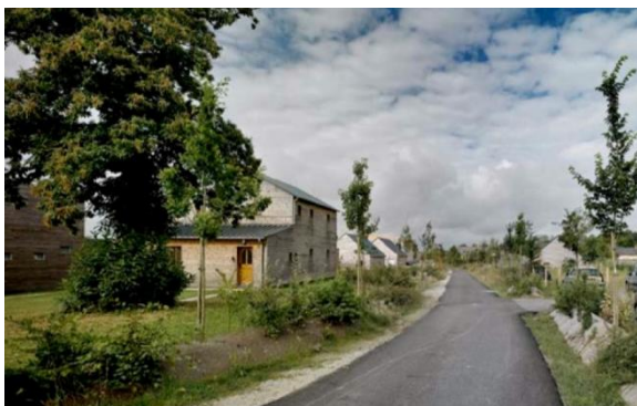
VOIRIE EN MILIEU RURAL : SIMPLE ET TRES VEGETALE
