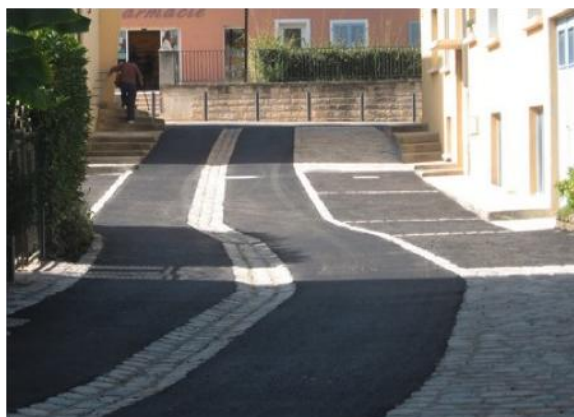
VOIRIE DE VILLAGE, GABARIT ETROIT, PARTAGE DES USAGES
