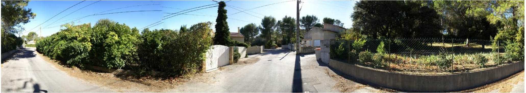
Les quartiers des Comminques et des Arènes, au réseau viaire organisé en impasses, à la couverture végétale épaisse et aux clôtures très marquée donne une sensation labyrinthe.
