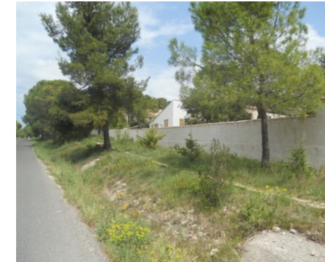
Cheminement le long de la RD137
