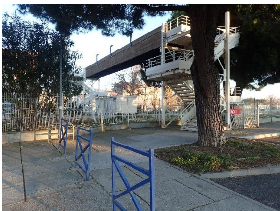
Passerelle au-dessus de la voie ferrée
