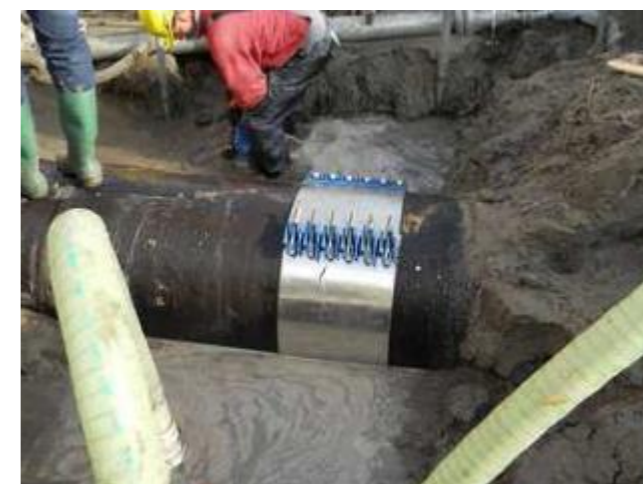
Illustration de la conduite acier Ø700 après réparation en 2014 :
