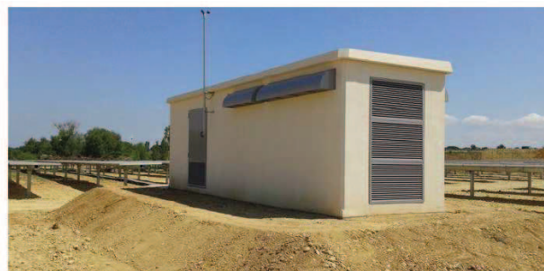
Exemple de Poste de livraison
