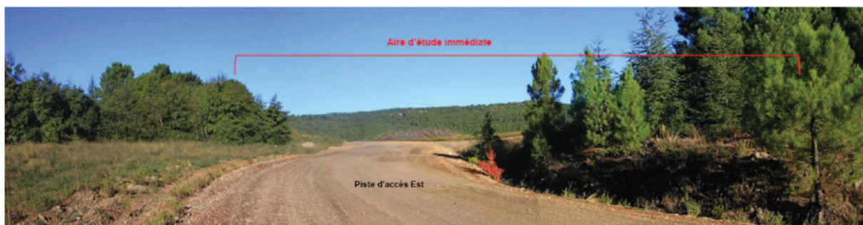
Vue de la piste d'accès Est
