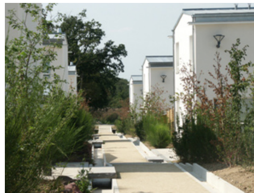
Desserte piétonne - ZAC de la Morinais - 35
