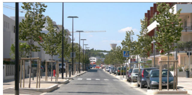
Voie de desserte principale - Malbosc Montpellier
