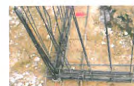
Noeud de chaînage - Continuité mécanique
