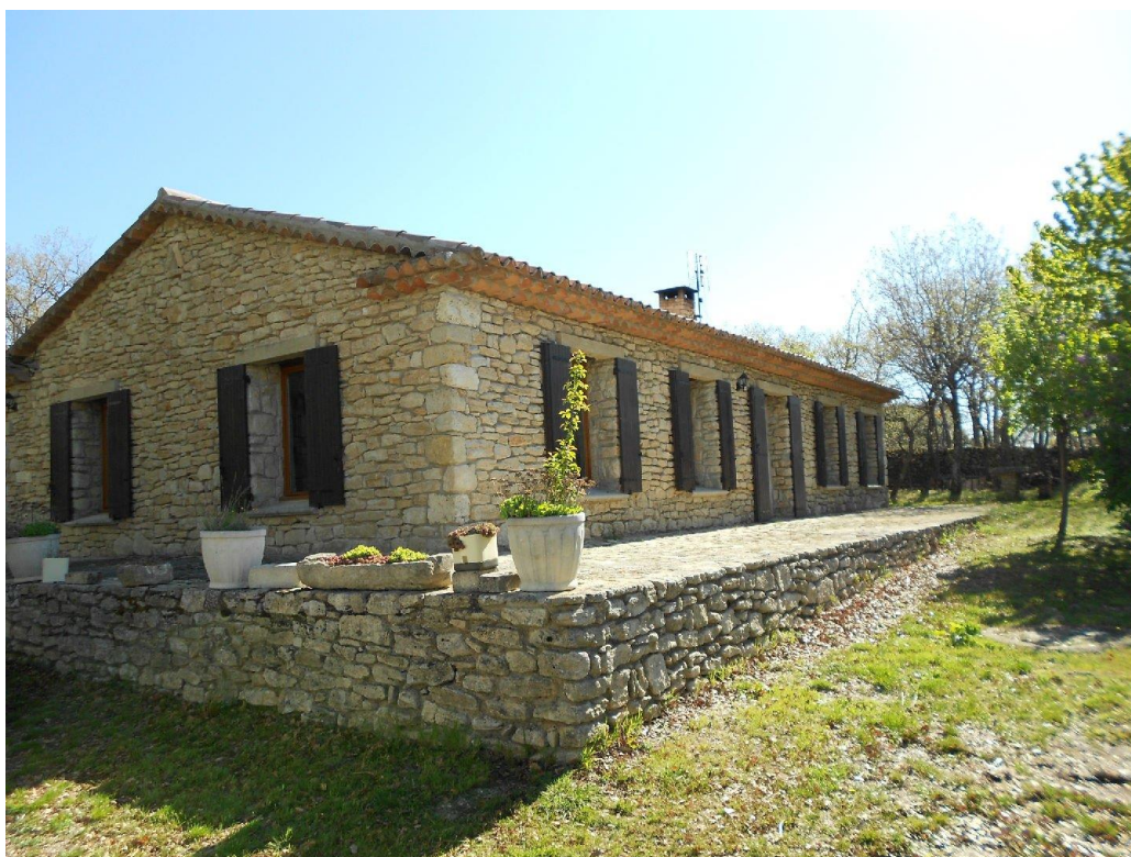
Photographie 3 : Exemple de maisons de plein pied en pierres (Photographie illustrative non opposable) (source : http://www.pierrestradition.com/details-vente+maison+de+campagne+5+chambres+a+viens+proche+du+village-590.html )
