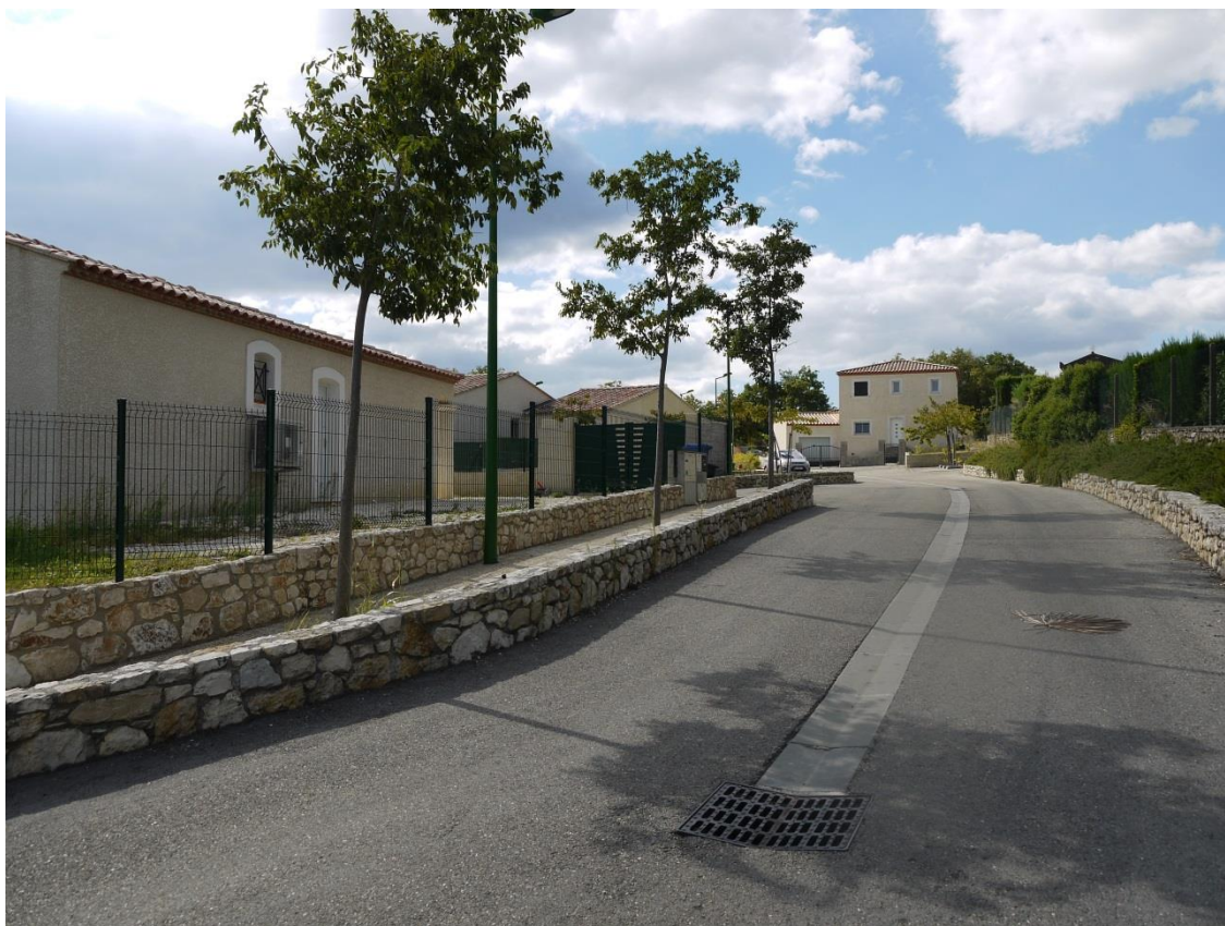
Photographie 4 : Traitement des bords de routes au quartier du soleil à Cruviers village (source : CSMC, sept.2016) Photographie illustrative non opposable
