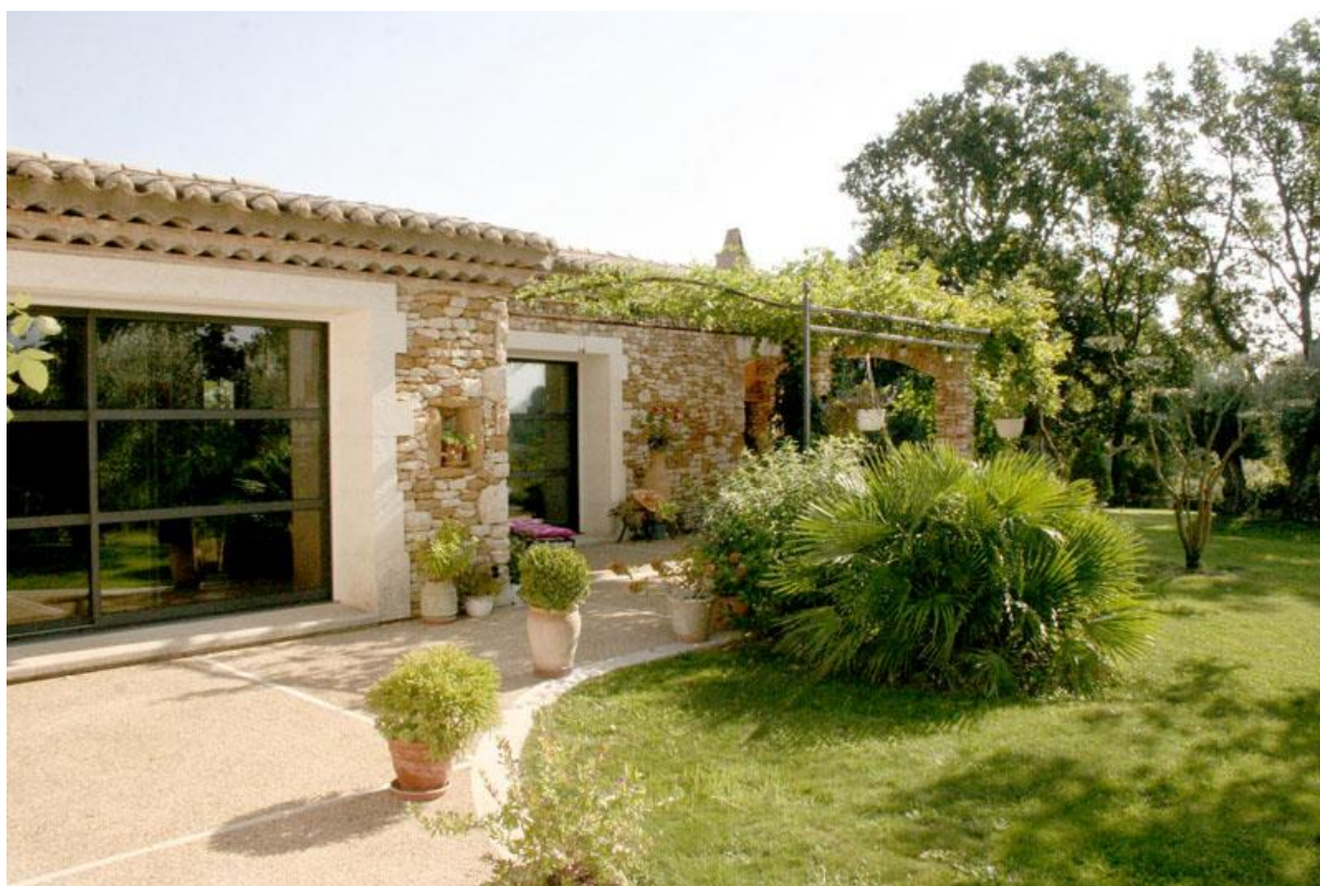
Photographie 1 : Exemple de maisons de plein pied en pierres (Photographie illustrative non opposable) (source : http://www.christinemiranda.com/details-maison-neuve-en-pierres-en-drome-provencale-quartier-tres-residentiel-superbe-realisation-de-plain-pied-1162.html )
