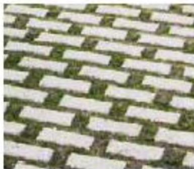
Pavage en béton avec ouvertures de drainage
