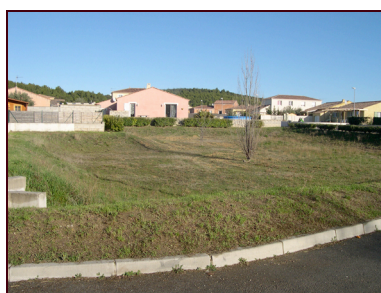
Bassin de rétention paysager lotissement de Laubre
