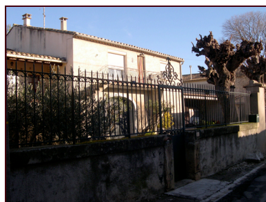
Bâti Rue du Temple
