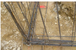
Nœud de chaînage - Continuité mécanique
