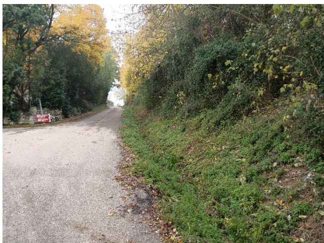
Figure 11 : Vue vers l'amont du chemin de la Vierge
