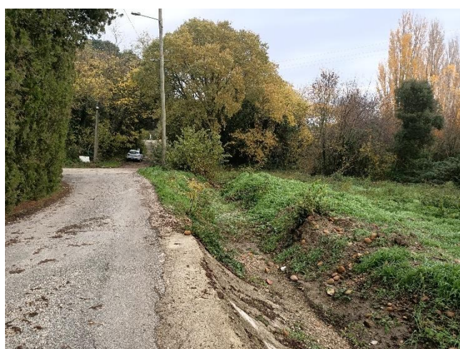
Figure 15 : Vue vers l'aval du chemin du Mas du Maire
