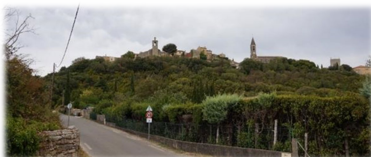
Entrée de ville depuis la RD n°192 en venant de VERS-PONT-DU-GARD
