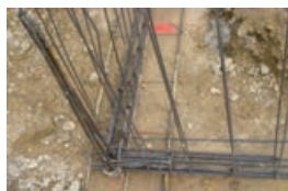
Nœud de chaînage - Continuité mécanique
