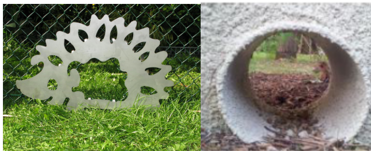
Figure 2 : Exemples d'ouvertures dans un grillage et un muret, prévues pour le passage de la petite faune
