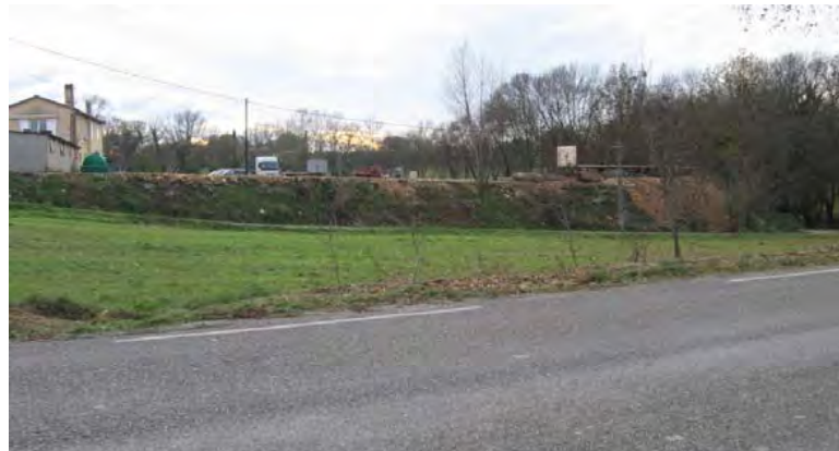
Remblai à Saint-Germain
