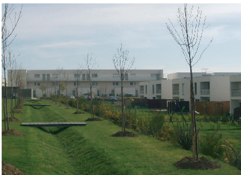
Opération mixte avec espace collectif et noues végétalisées (Ile et Vilaine)
