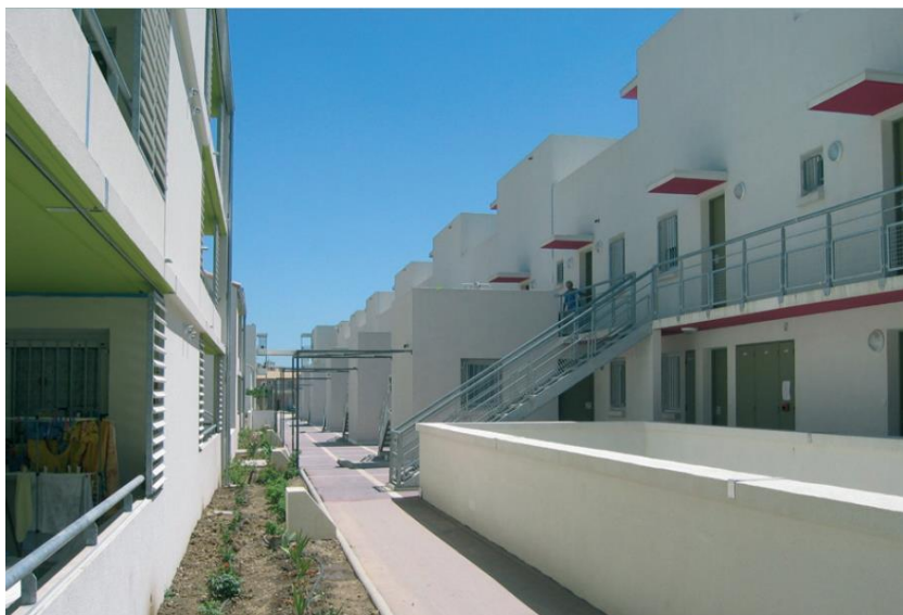
Habitat groupé et petits collectifs avec cheminement piéton (Gard)
