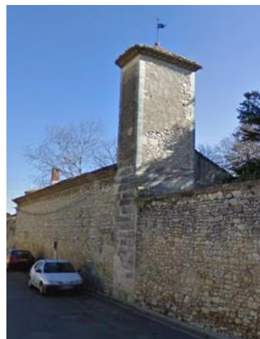
Tour existante rue Croix du Sang
