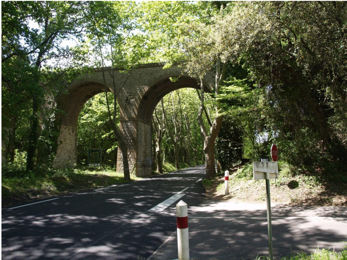
RD 982, Ancienne voie ferrée
