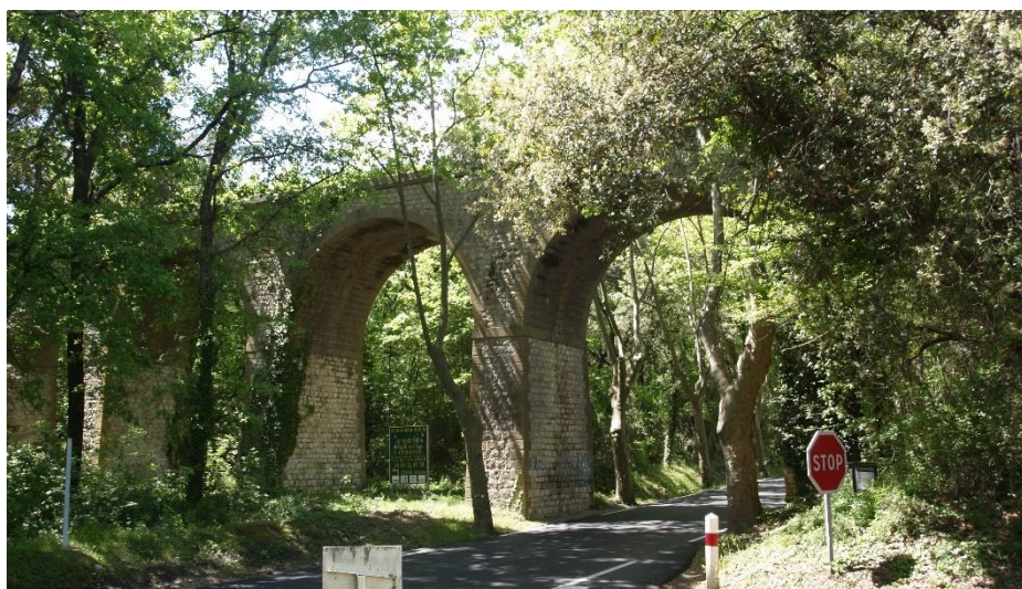
Viaduc de l'ancienne voie ferrée enjambant la RD n°982
