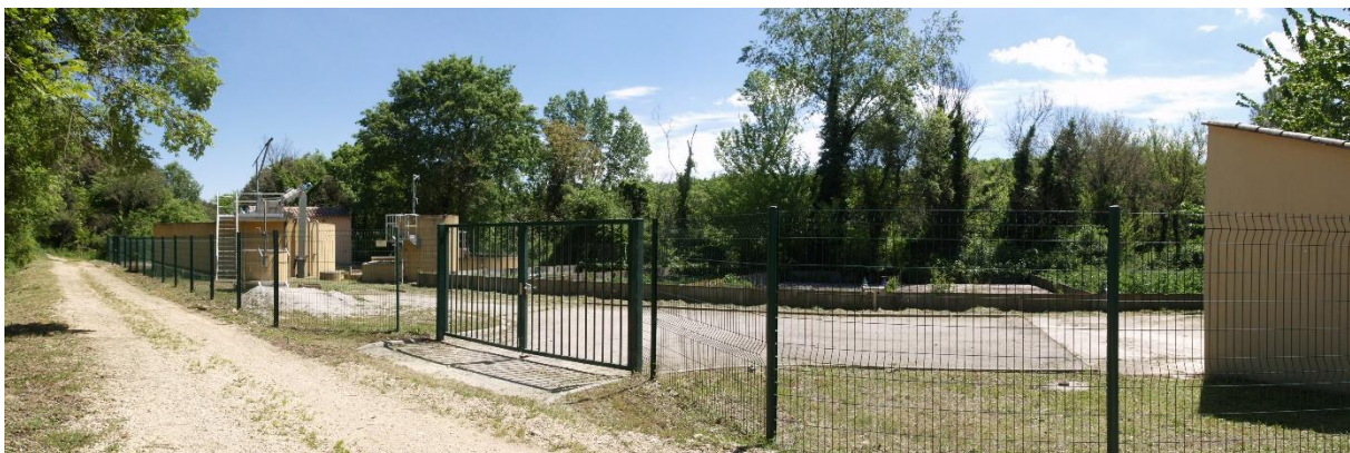
La station d'épuration d'ARPAILLARGUES
