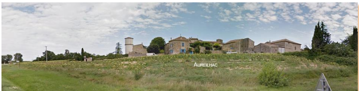
3. Vue sur Aureilhac depuis la RD n°982
