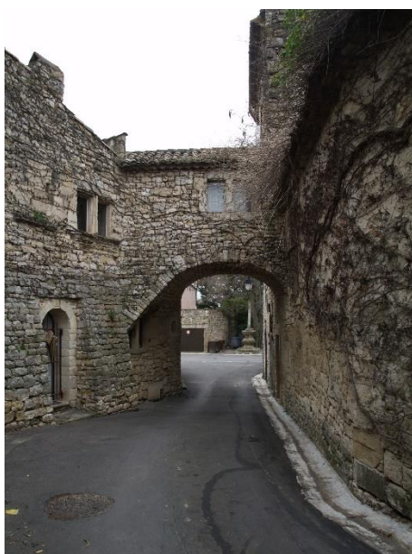
Arche de pierre enjambant la rue de l'Eglise
