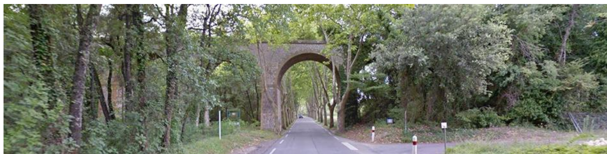
12. Vue sur le viaduc de l'ancienne voie ferrée sur la RD n°982 vers Uzès
