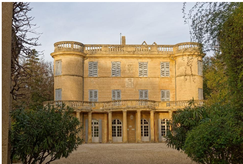
Ensemble patrimonial et architectural du Domaine de Castille Protégée au titre de l'article L151-19 du code de l'urbanisme
