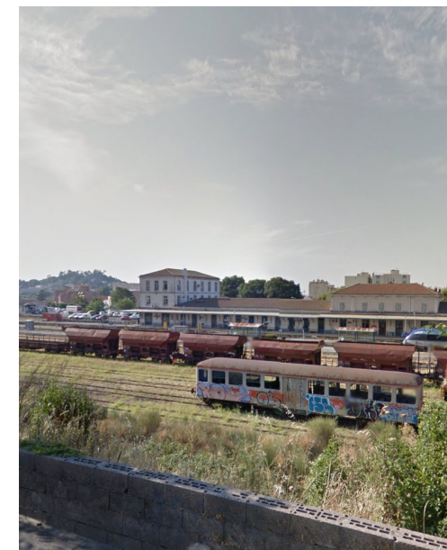
Alès // vue sur la friche ferroviaire, site d'un possible Ecoquartier (foncier non communal)
