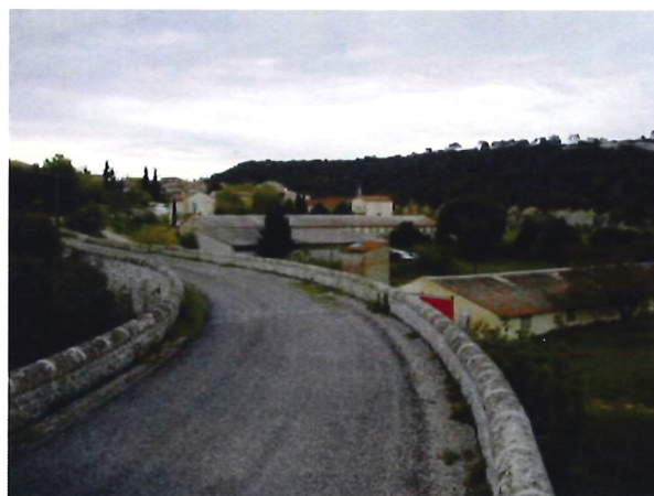
Photo 54. Les bâtiments agricoles vus du pont
