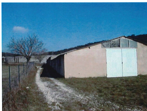
Photo 51. Bâtiment agricole rive droite
