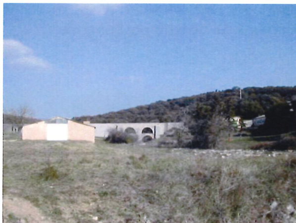
Photo 53. Le viaduc et les bâtiments agricoles
