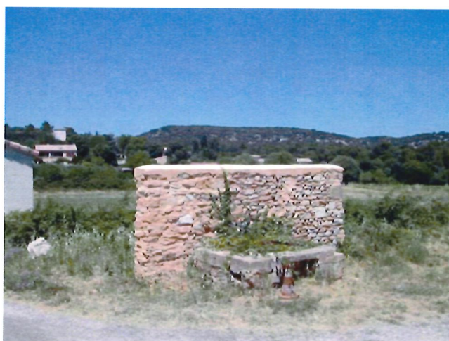
Photo 95. Puits à Gattigues
