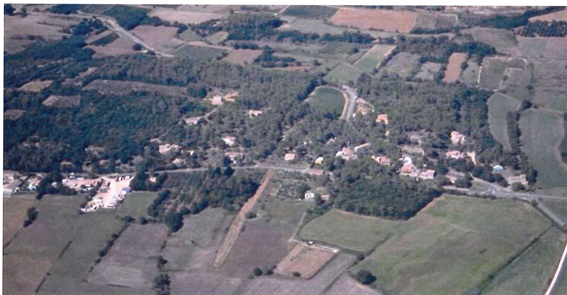
Photo 69. Champ des Baumes, vue aérienne
