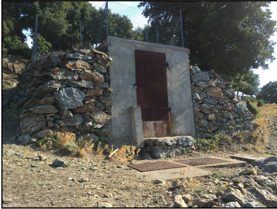
Vue générale du réservoir - Vue de la dalle de couverture
