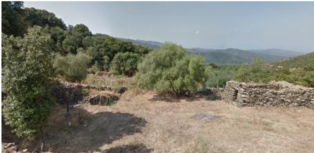
Aménagements de terrains agricoles à Batolaccio : murets et murs de soutènement en pierres sèches, bâtiment agricole historique en co-visibilité avec la vallée de l'Ostriconi.
