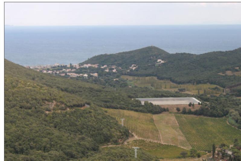
> Photographie : Vue sur le réservoir d'eau de l'OEHC
