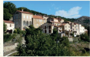
La maison de maître se détache par son volume. Les grandes ouvertures éclairaient la loggia
