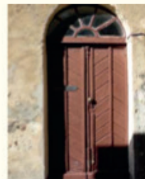
Porte d'entrée à 2 lits de planches croisées, obliques à l'extérieur, verticales à l'intérieur.
