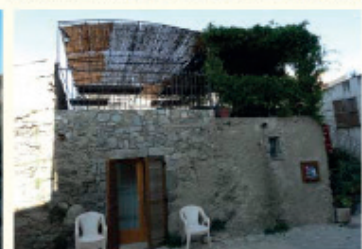
Protection de terrasse en roseaux
