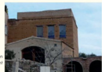
Capteurs à air placés en retrait de la façade imitant des baies vitrées
