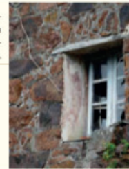
Enduit de tuf à Poggia recouvert d'un lait de chaux blanc.
