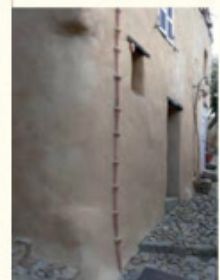
Les descentes semi-encastrées en terre cuite sont plus adaptées à l'architecture des villages.
