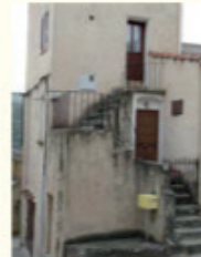
Garde-corps en ferronnerie légère
