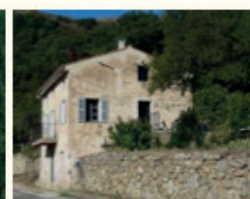
Le muret assure une continuité bâtie entre la construction et le paysage rural aménagé.
