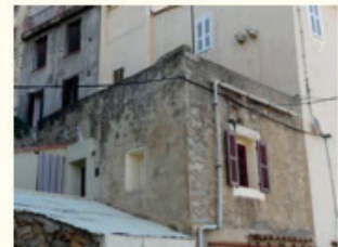
Les dispositifs traditionnels sont remplacés par des éléments en PVC
