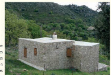
Toiture-terrasse créée sans acrotère. Ses formes de pente particulières permettent l'évacuation directe des eaux pluviales
