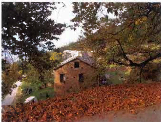
MONTE (maison isolée en pierre, à l'entrée du hameau)
