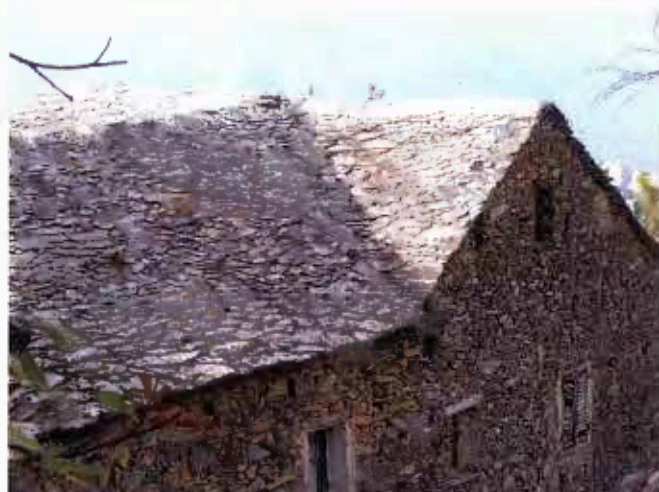
MONTE (Maison ci-dessus, couverture en lauzes)
