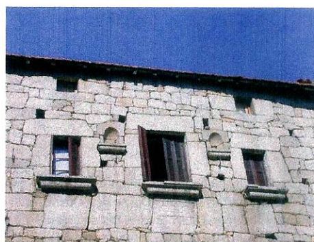
Forciolo – Détail des fenêtres de l'étage noble. Les appuis monolithes sont sculptés. Les pierres des allèges posées de champ présentent des faces approximativement carrées.
