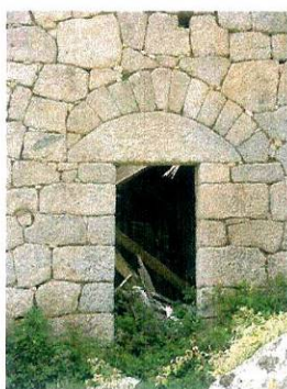
Zerubia – Détail porte- linteau avec extrados cintré et arc de décharge.
