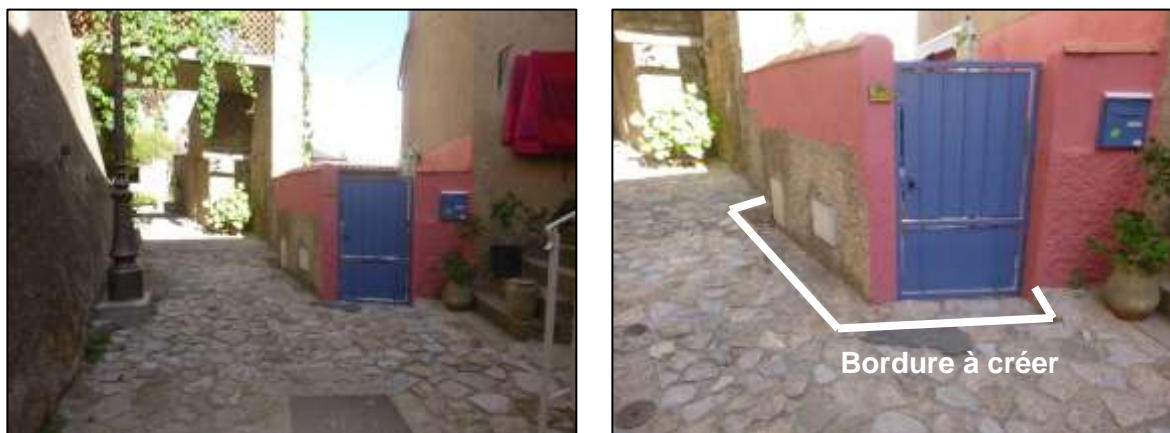
Photo 2 : Localisation du problème structurel sur le village haut (26/09/2019)
