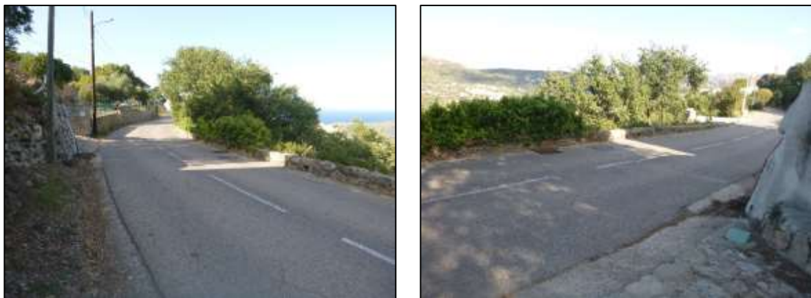
Photo 4 : Localisation des deux regards bouchés à l'Ouest du village (25/09/2019)
