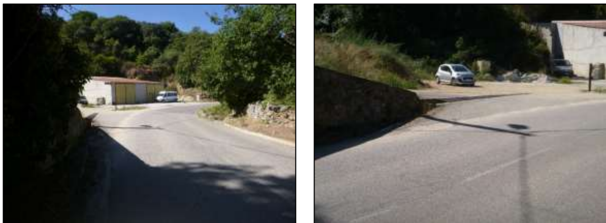
Photo 5 : Localisation du chemin de grille ensablé à proximité du hangar (27/09/2019)
