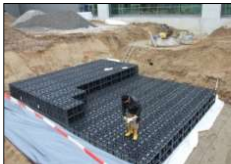
Photo 9 : Mise en place d'un bassin enterré à structure alvéolaire
